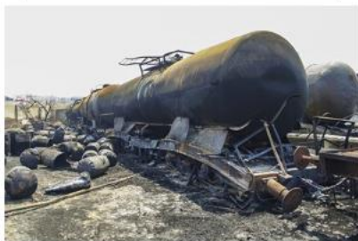
Centrale électrique de Jiyeh, après un bombardement israélien - 2006
