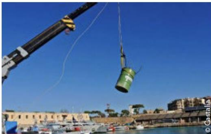
Image : Hissage d'un fût avec un filet de récupération
